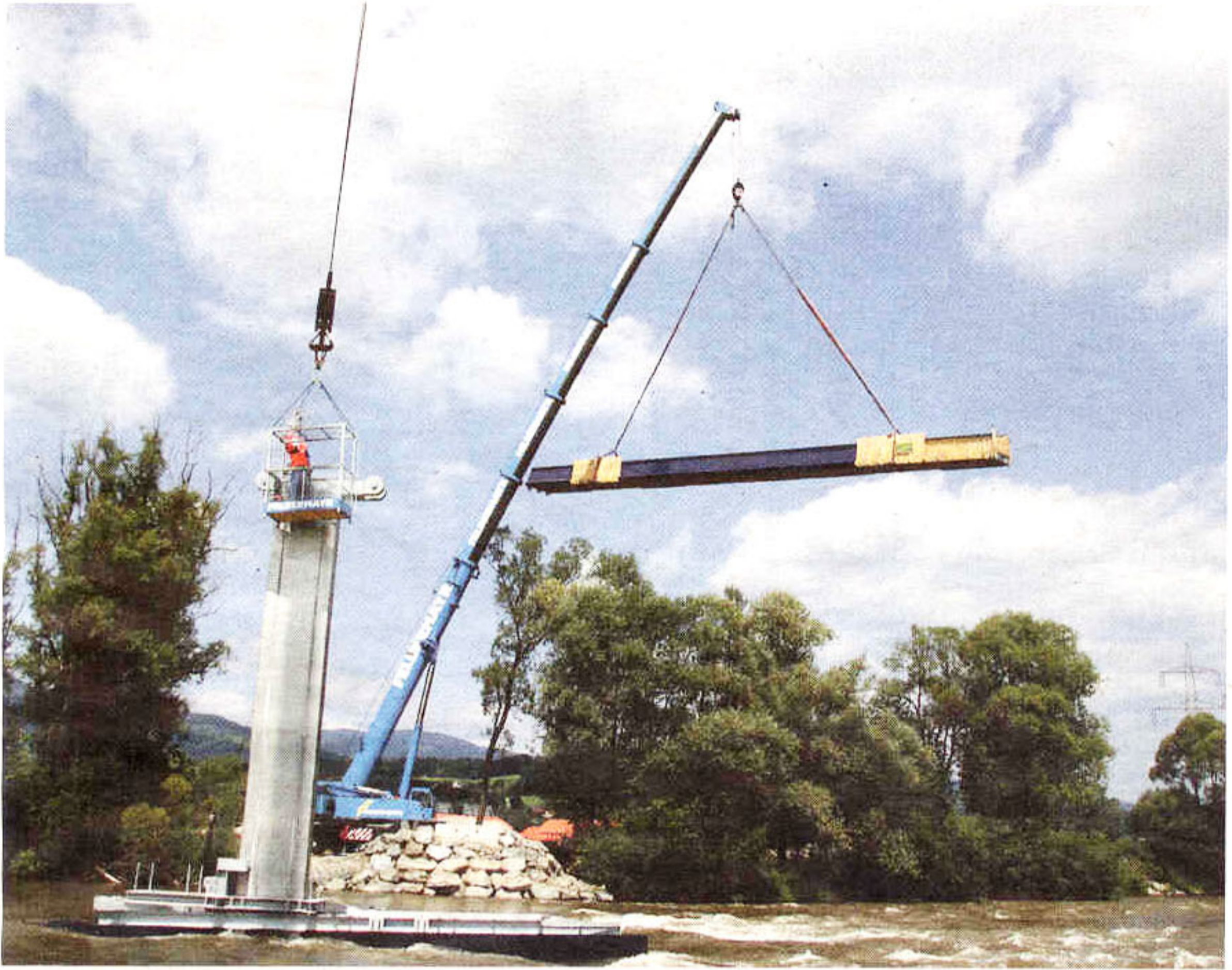
Da schwebte sie gestern noch hoch über dem Wasser, die beiden Brückenteile sind je 16 Tonnen schwer
