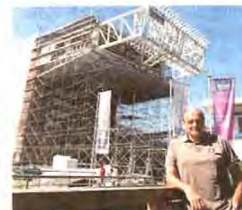
Klaus Bartelmuss vor dem Rohbau des IBS-Towers FRÖHLICH
