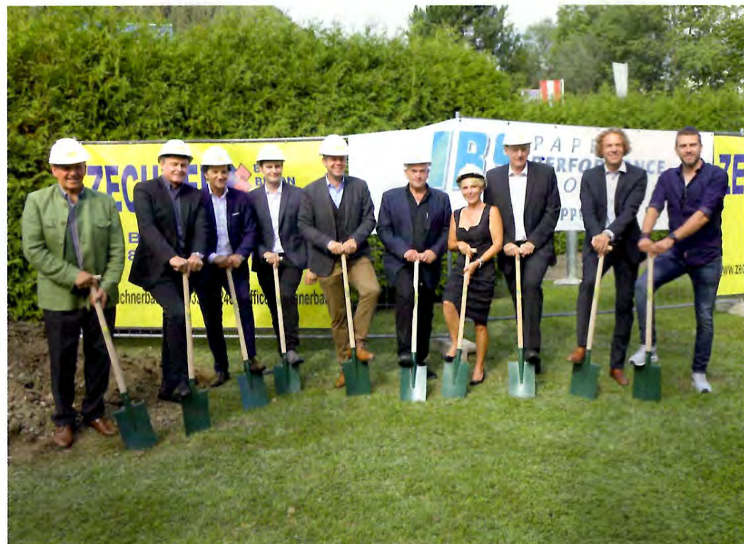
Der Spatenstich für dieses „Leuchtturmprojekt“ der weltweit erfolgreichen IBS Paper Performance Group mit Headquarter in der Gemeinde Teufenbach-Katsch wurde im September 2019 gesetzt.
