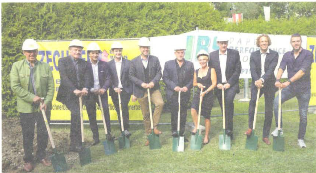
IBS-Eigentümer Ing. Klaus Bartelmuss mit CEO/CFO Dr. Marc Kaddoura (2. u. 3. v. l.) mit Planern und Bauausführenden beim Spatenstich, zu dem sich auch Ex-Bürgermeister Johann Gruber (l.) eingestellt hat.
