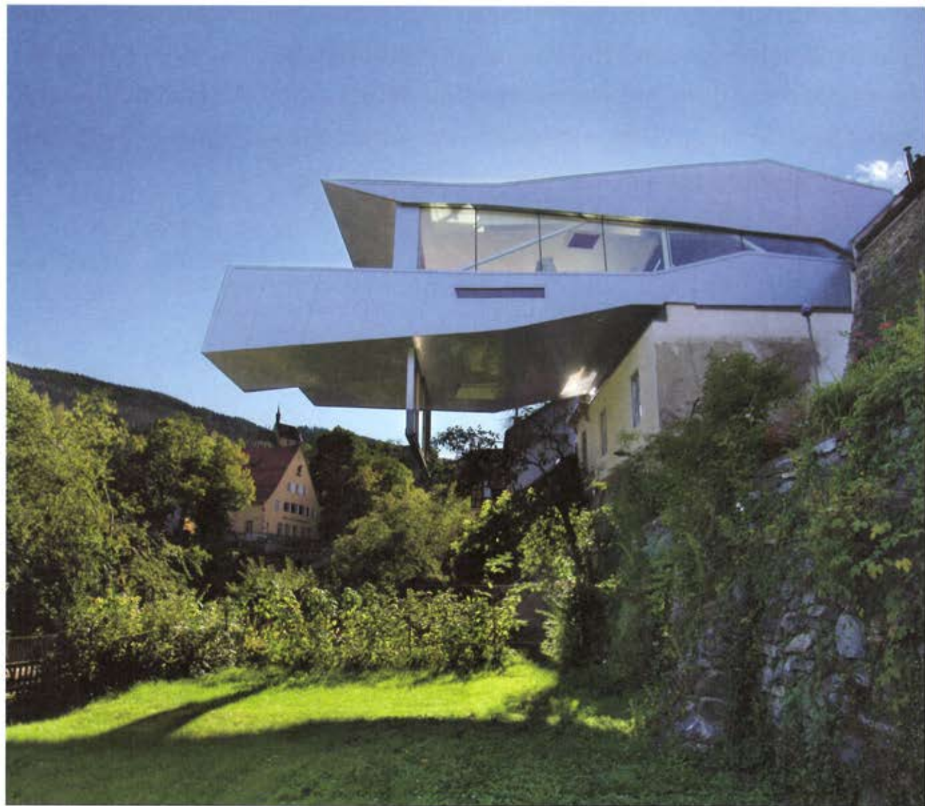
Mehr als 12 m krägt die Holz-Stahl-Hybridkonstruktion aus, Murau
